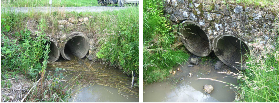
Vues de l'amont et de l'aval de l'ouvrage
