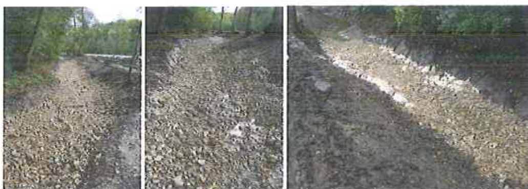
Création d'un matelas alluvial et aménagement d'un seuil ennoyé
