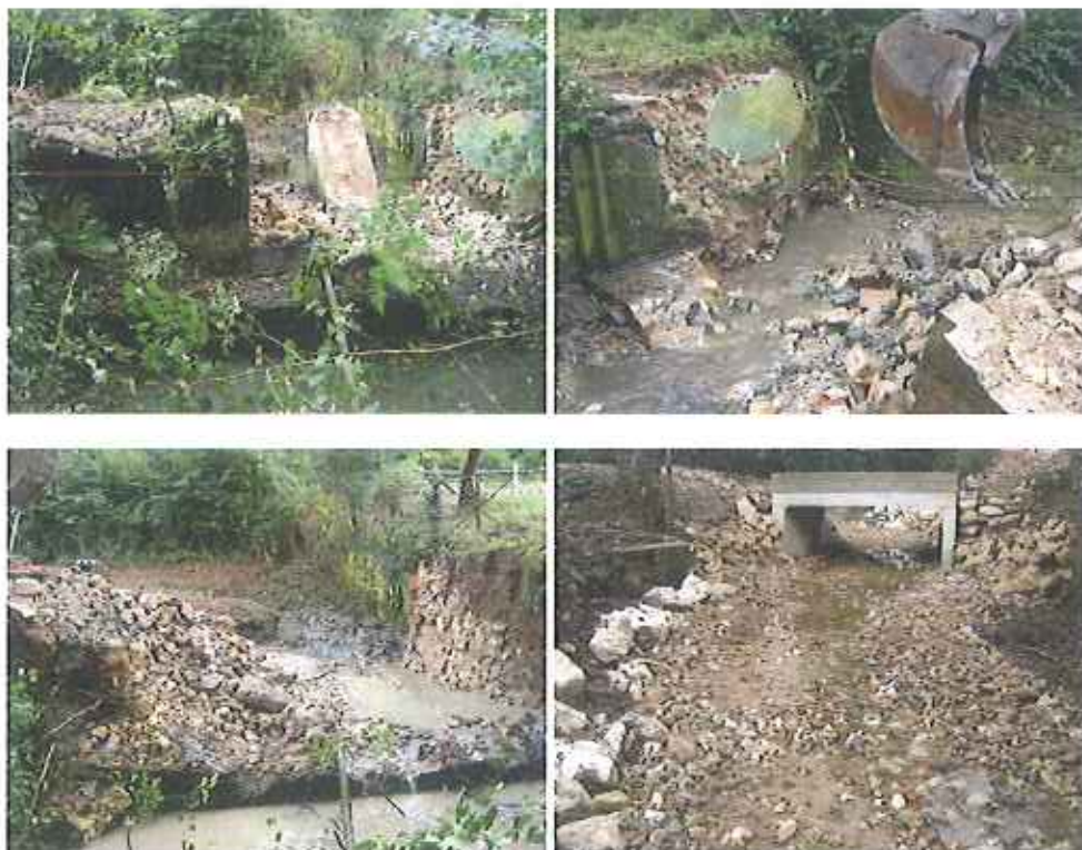
Démolition de l'ancien vannage et aménagement d'un pont cadre
