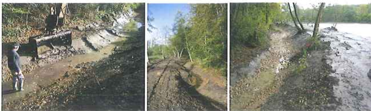
Reprofilage du lit avant recharge
