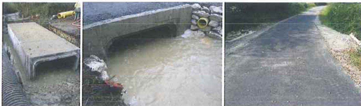
Ouvrage de franchissement du Moulin de Berton (Nouzilly)
