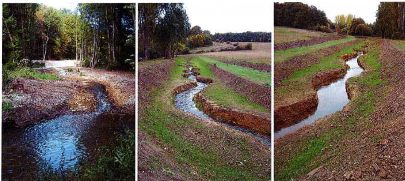
Vues de la rivière de contournement de l'aval vers l'amont
