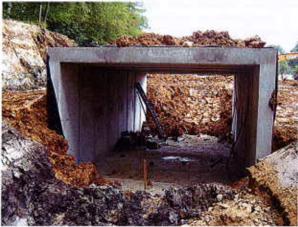
Pose du cadre et terrassement du bras de contournement
