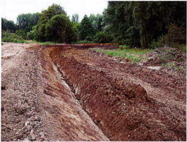
Pose du cadre et terrassement du bras de contournement
