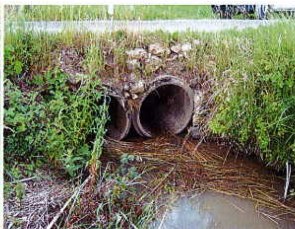
Vue amont ouvrage
