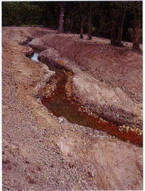
Habillage de la digue et création de l'armature de fond du lit par recharge en matériaux alluvionnaires
