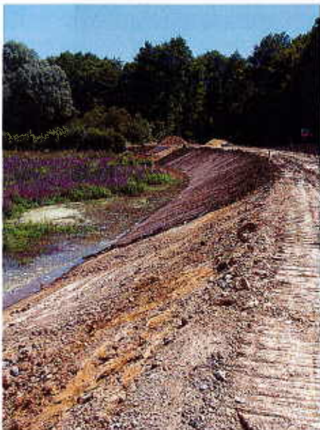
Habillage de la digue et création de l'armature de fond du lit par recharge en matériaux alluvionnaires
