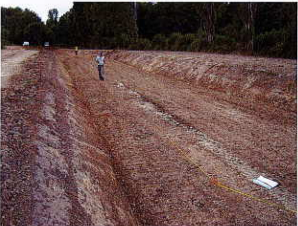
Traçage du lit de la rivière de contournement et terrassement
