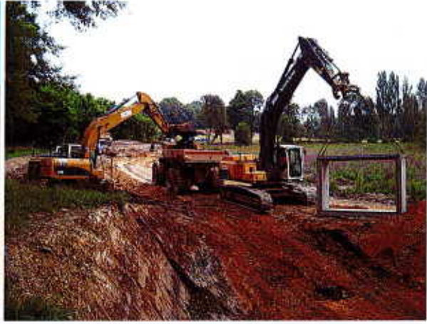
Terrassements pour la préparation de l'assise de la digue et de la pose du pont cadre
