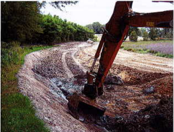
Traçage du lit de la rivière de contournement et terrassement
