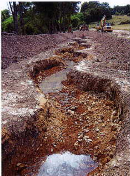
Habillage de la digue et création de l'armature de fond du lit par recharge en matériaux alluvionnaires
