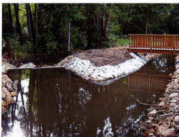
Ouvrage de répartition amont et mise en eau de la rivière de contournement
