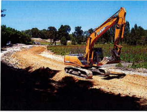
Terrassements pour la préparation de l'assise de la digue et de la pose du pont cadre
