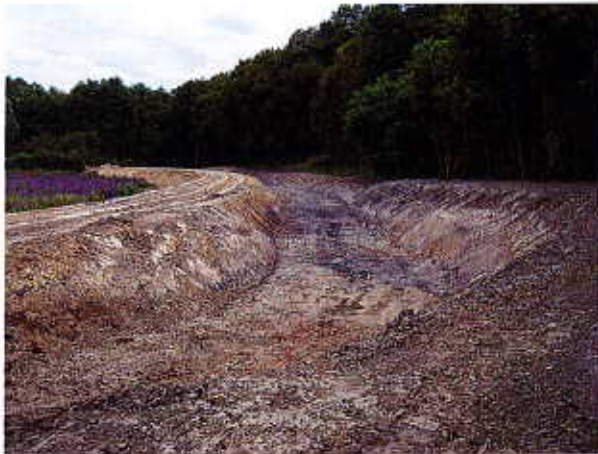
Contrôle des terrassements de la rivière de contournement par l'ONEMA
