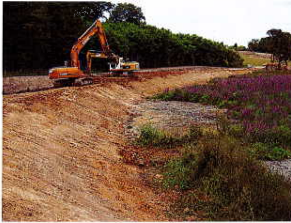
Aménagement de la digue et traçage de la rivière de contournement
