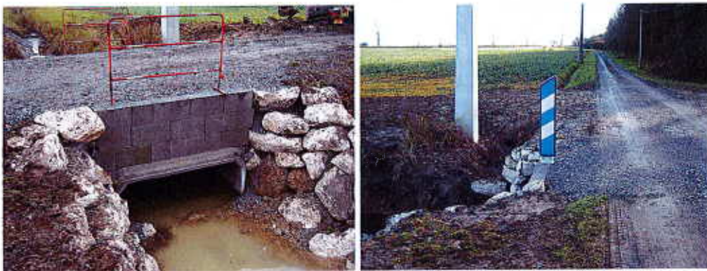
Compactage de la diorite, joints de liaison des blocs en béton, fixation des balises
