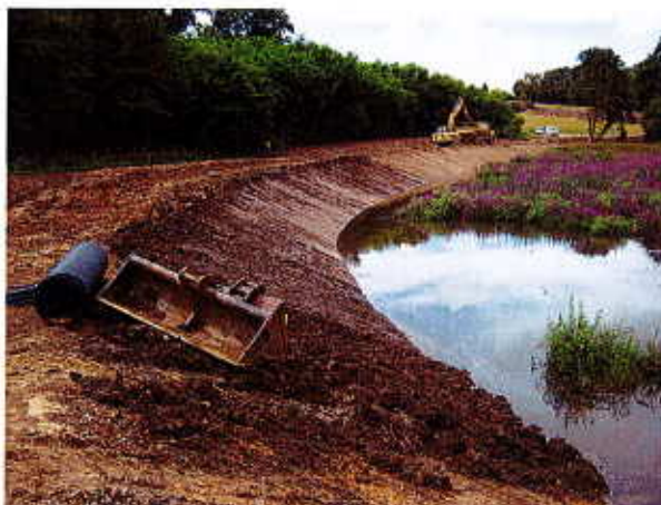
Remise en eau progressive du plan d'eau et rivière de contournement le long de la digue
