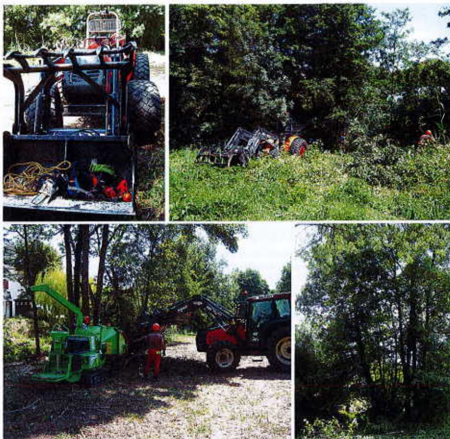
Engins mis en œuvre pour réaliser les travaux
