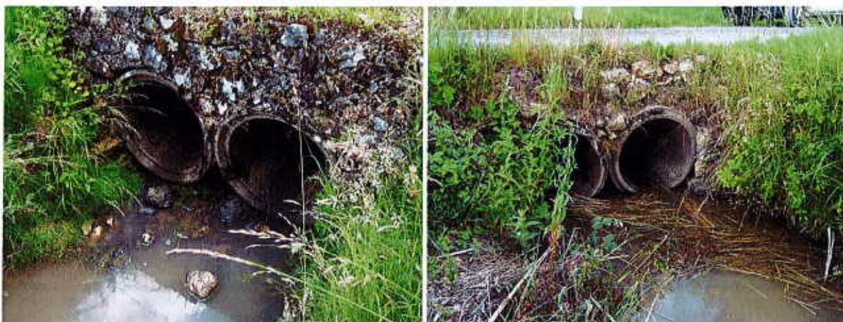
Vue aval et amont de l'ouvrage avant travaux
