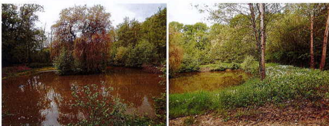
Vue générale du plan d'eau et de la digue aval
