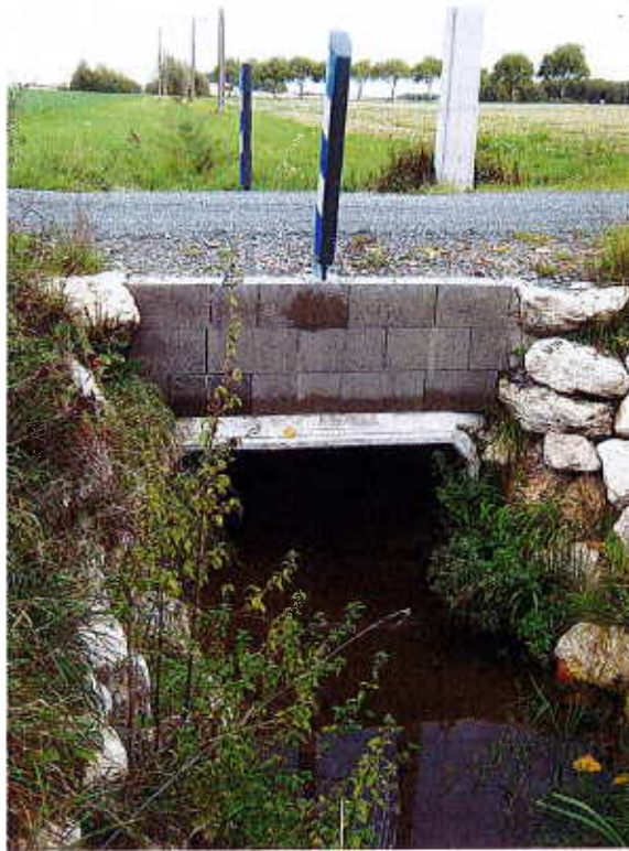
Vue aval de l'ouvrage après travaux
