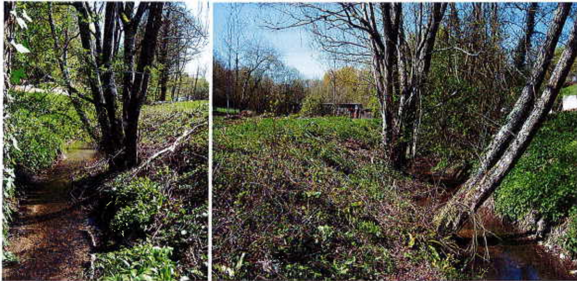
Vue de la digue latérale bordant le Ruisseau de Saulay
