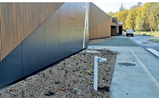
Du gazon a été semé et des plantes ont été disposées tout autour du bâtiment. Le fruit de ces plantations sera visible dès le printemps prochain.
