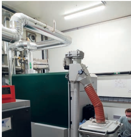
Suite à la mise en service de la chaufferie, un test de fumée est effectué annuellement et permet de vérifier la conformité des rejets. Rappelons que cet équipement vertueux chauffe 6 bâtiments communaux.
