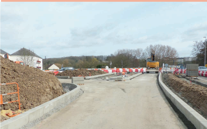
MARS : DÉFINITION DES ZONES VERTES, SORTIE DE TERRE DES PREMIERES BORDURES DE DÉLIMITATION
