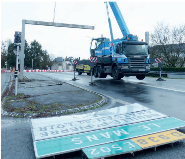
FÉVRIER : DÉMONTAGE DES PORTIQUES DIRECTIONNELS, DES GLISSIÈRES DE SÉCURITÉ ET DES ÎLOTS SÉPARATEURS.
